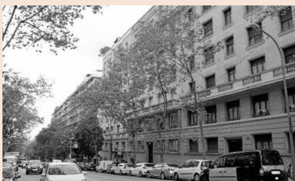
El edificio se encuentra en el número 433 de la calle Balmes.
