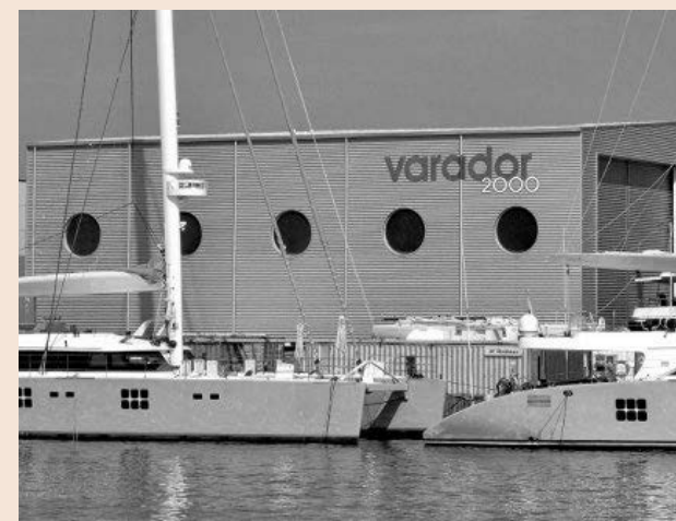
Instalaciones de Varador 2000 en Arenys de Mar (Maresme).
