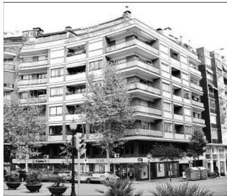
Alting ha comprado un edificio en la plaza San Gregorio Taumaturgo.
