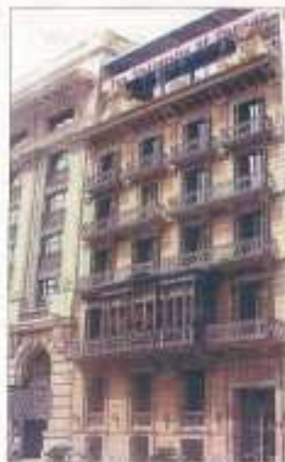
Edificio adquirido por Alting.
